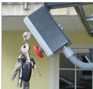
1 - замковый выключатель 2 кнопка аварийной остановки
